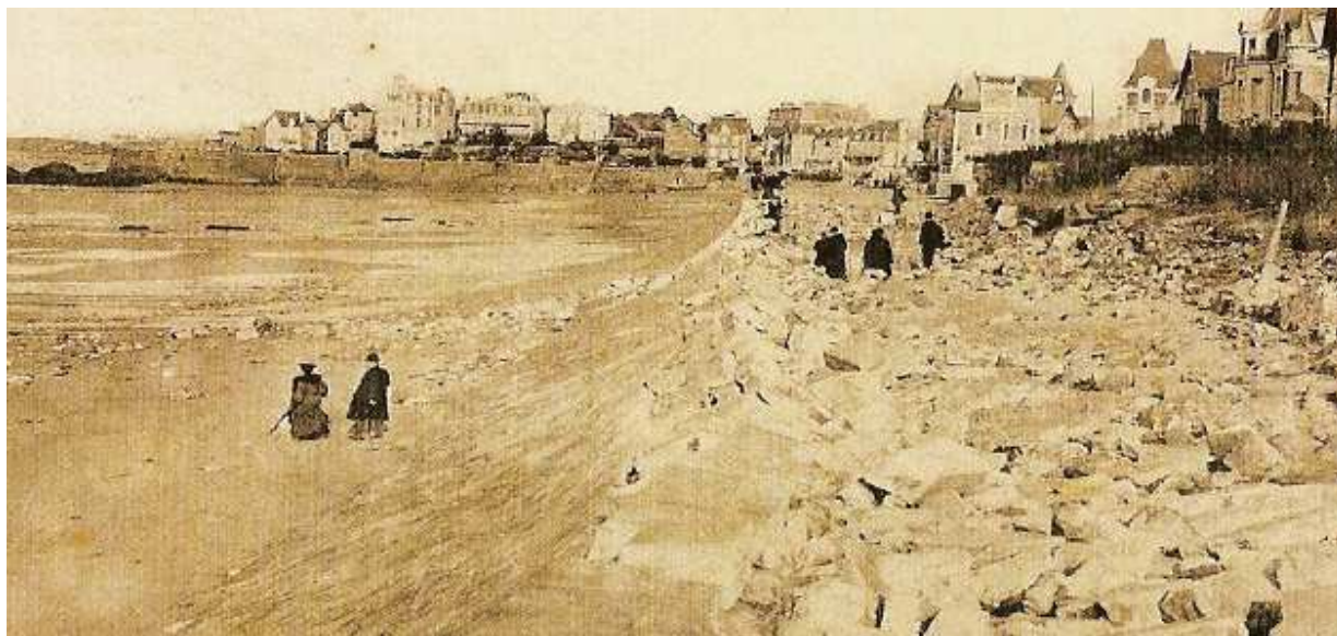
Figure 19 : Dégâts après le « raz de marée » d'octobre 1905. Plus de joint entre les blocs du cantelage et les blocs de la paroi. Le haut de l'ouvrage est érodé et s'est affaissé. Des maisons sont « éventrées ». (document des archives départementales collecté par le CETE de l'ouest pour le compte de la DDTM35/DREAL).
