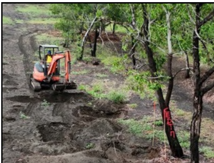
Ouverture de potets de plantation à la pelle mécanique
